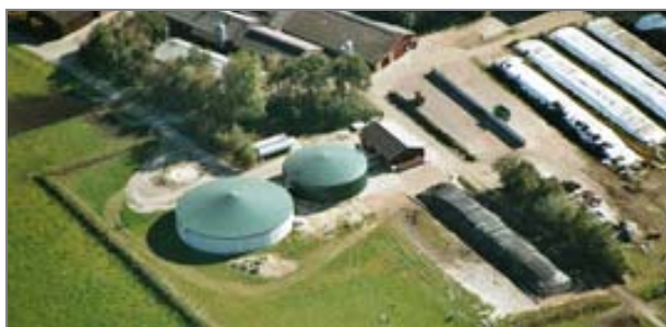
Beispiel einer 500 kWel Biogasanlage, Quelle: www.envitec-biogas.de
