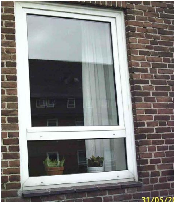
Die Fenster scheinen ersatzbedürftig.
