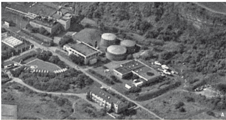
Die Meerwasser-Entsalzungsanlage der Versorgungsbetriebe Helgoland
