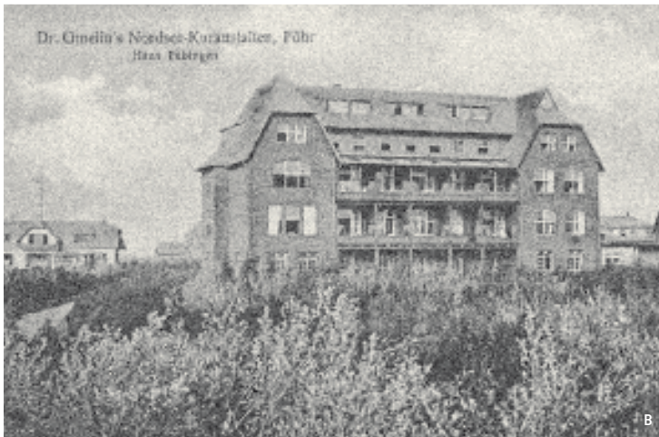
Nordseesanatorium Haus Tübingen
